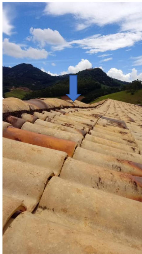
Figura 03 – Telhado lado direito.
