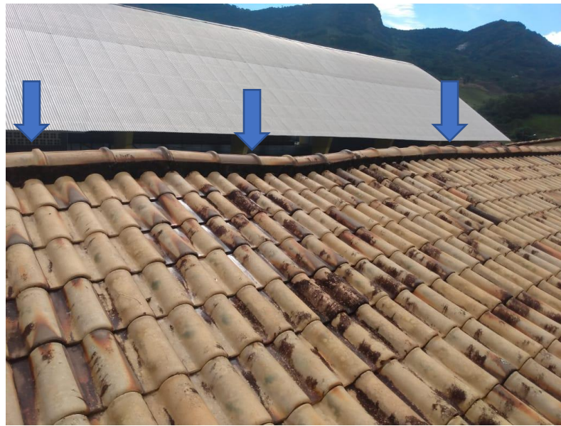
Figura 02 – Telhado lado esquerdo.
